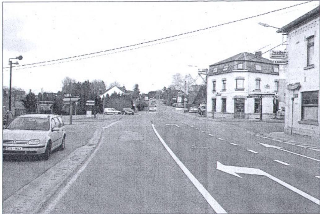
Les quatre bras à Bois-de-Villers : détracteurs et partisans d'un parc à conteneurs rue Binamé Bajart sont d'accord là-dessus, ce carrefour sera encore plus dangereux avec l'installation de ce parc. Et le MET n'est pas décidé à revoir sa copie, dans l'immédiat. Philippe BERGER
